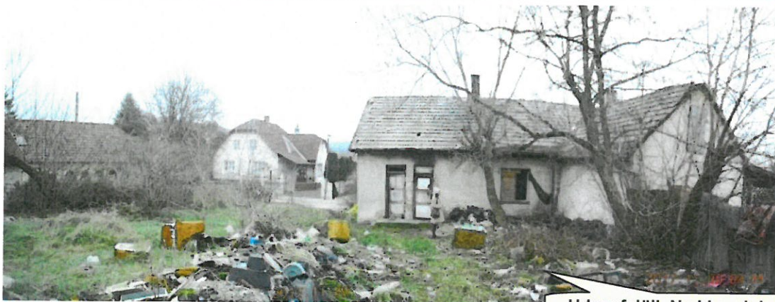
Udvar felőli, Ny-i homlokzat
