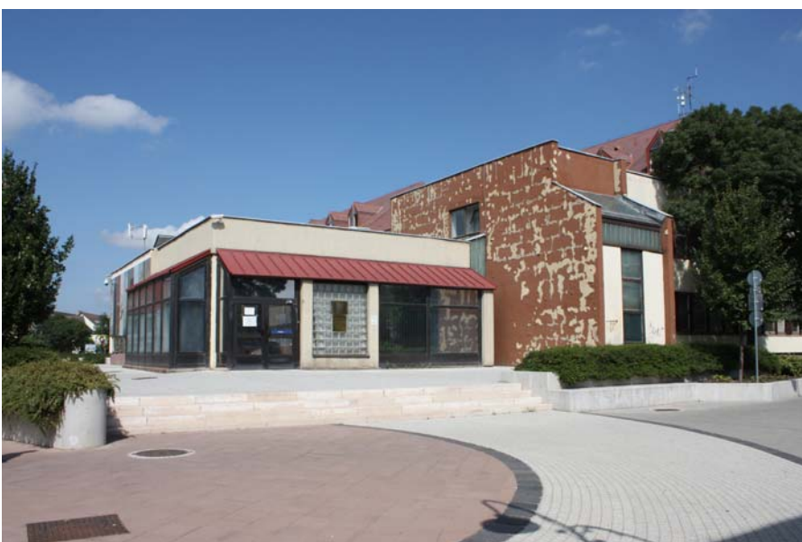
GÖDÖLLŐI VÁROSHÁZA BONTÁSA 2100 GÖDÖLLŐ, SZABADSÁG TÉR 7. HRSZ.: 291/4 BONTÁS TUDOMÁSULVÉTELI ELJÁRÁSÁHOZ SZÜKSÉGES DOKUMENTÁCIÓ
