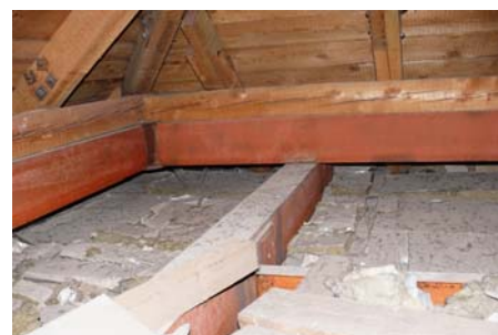
BEÉPÍTETLEN TETŐTÉR / KŐZETGYAPOT HŐSZIGETELES
