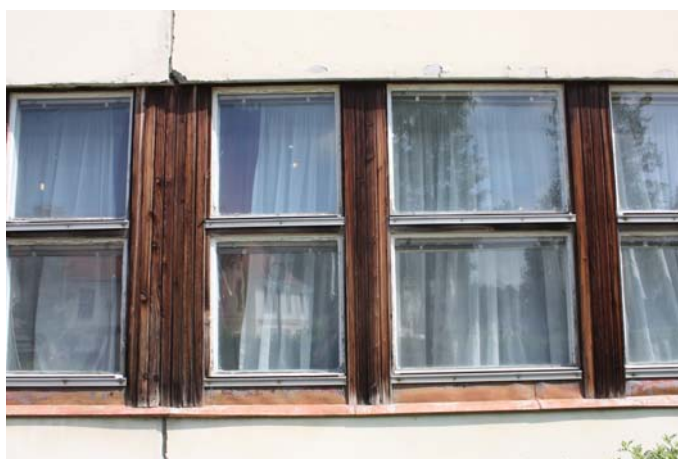
HOMLOKZUATI RÉSZLET / SZALAGABLAK ÉS VASBETON SZENDVIPANEL TALÁLKOZÁSA
